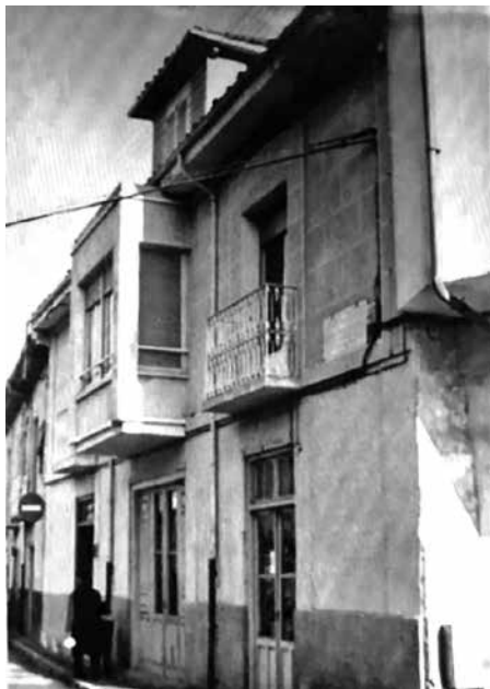
Casa de Escolástica Pérez Cordero, colindante con la de Ferreras
