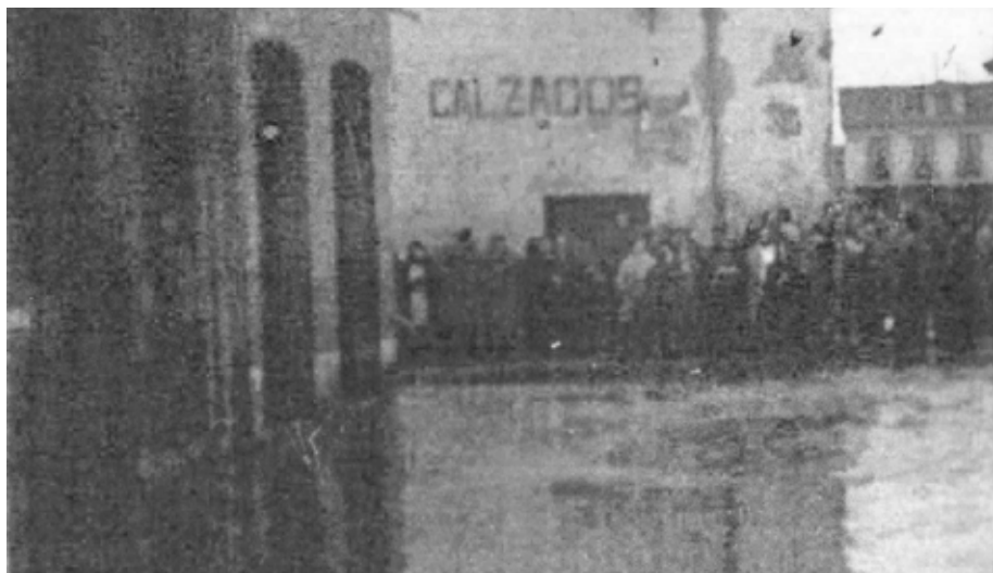
Vista del agua discurriendo por el cruce de las
